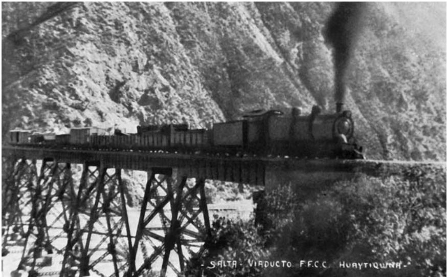
Viaduc transandin FFCC Huaytiquina à plus de 4500 m. au-dessus du niveau de la mer.
