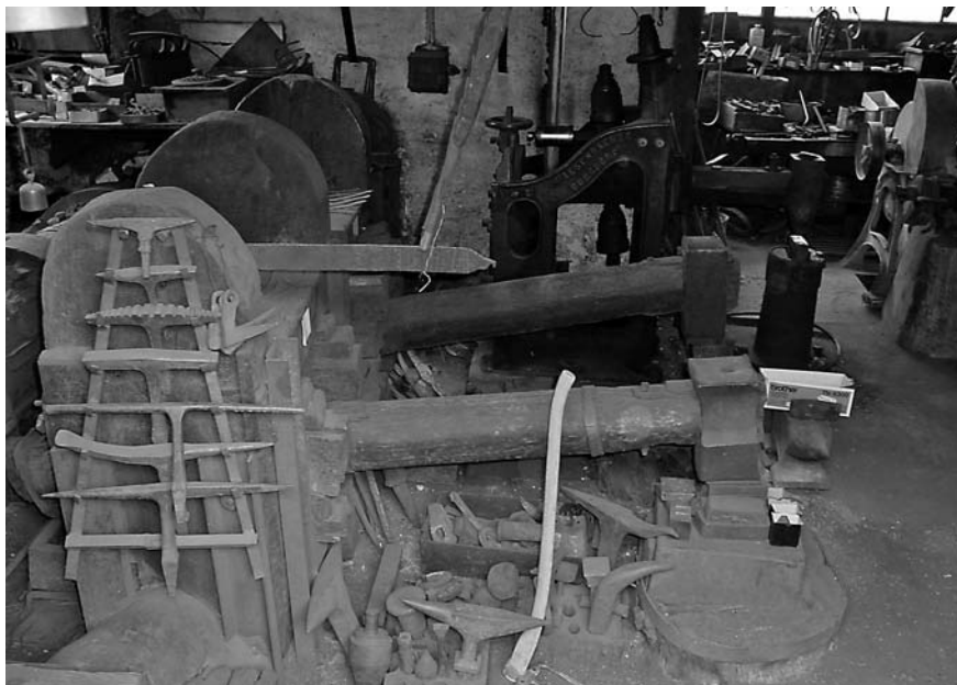
Le martinet est un engin composé d'un marteau placé à l'extrémité d'une longue queue horizontale. Un arbre à came entraîné par une roue hydraulique lui procure le mouvement. (Forge Lugon-Moulin, Martigny-Bourg).
