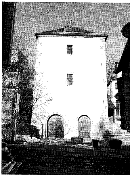
Depuis 1698, la «Maison du Sel» a succédé à l'ancienne tour des Montheolo. (Source: PAB)
