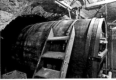
La Bernarde, tonneau de 12 000 litres daté de 1736, sert de réservoir d'eau potable. L'eau qui arrive de manière naturelle jusqu'au 3<sup>e</sup> est ensuite pompée dans les étages.
