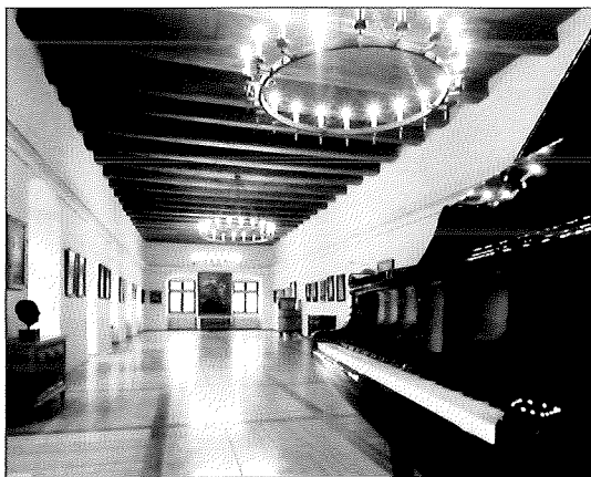
Salle des chevaliers. Au plafond, les poutres massives en mélèze montrent bien que le château ne fut jamais achevé : elles ont été conçues pour recevoir un plafond à caissons.
