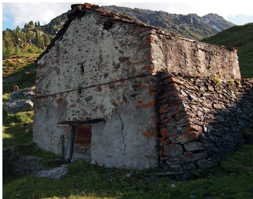
Fromagerie de l'alpage d'Orzival. Photo J.L. Perruchoud
