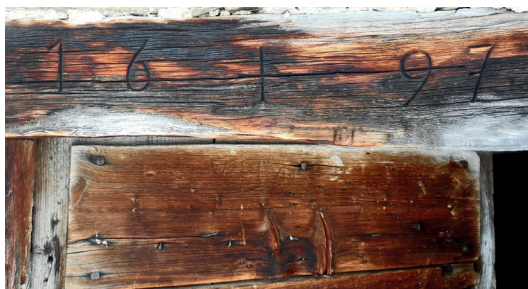
Poutre de la fromagerie datée de 1697 Photo J.L. Perruchoud
