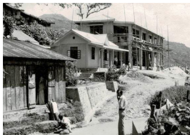
Construction à Kalimpong © Emmanuel Gex-Collet, 1974
