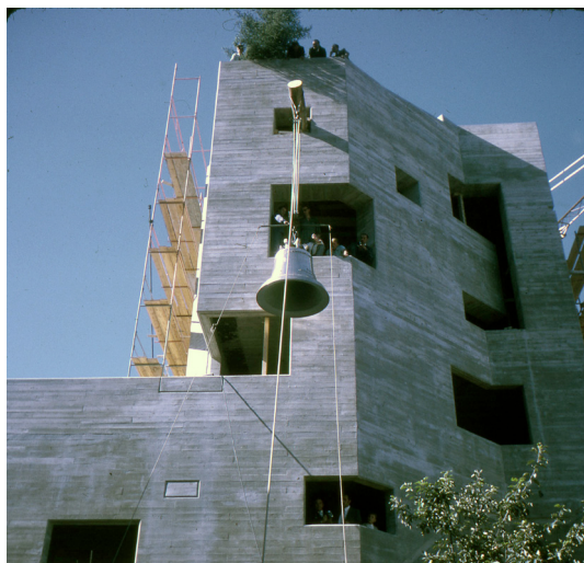
Construction de l'Eglise d'Hérémente , 6.9.1970, montée des cloches après la bénédiction
